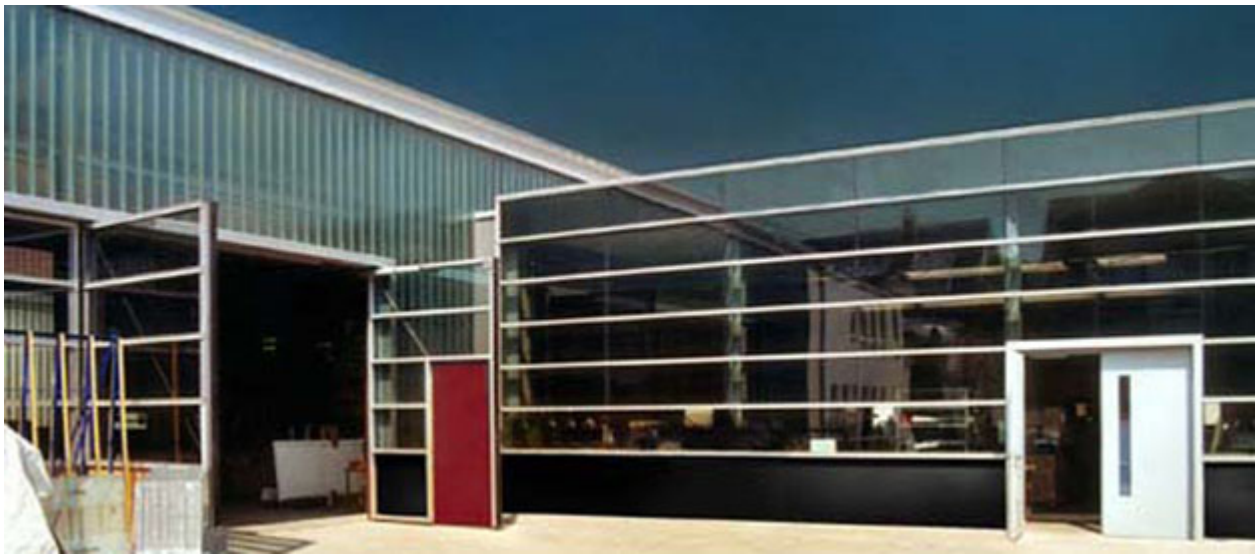
Glasfassade und Tore der Schlossereihalle
